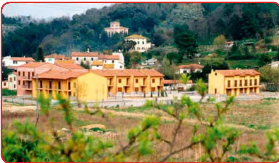
Figura 4 – Vista generale della realizzazione di figura 3.
